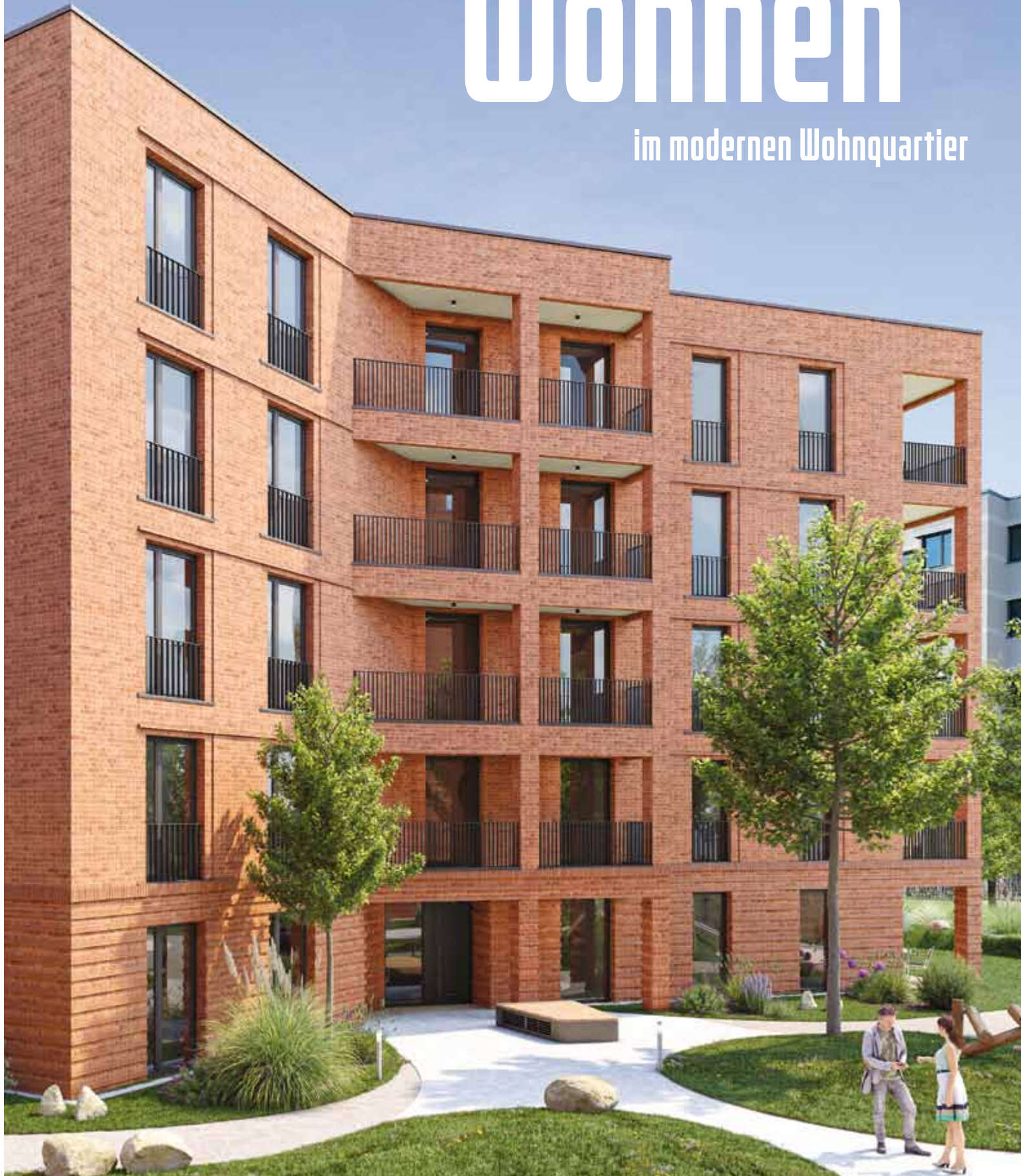
10/11 Blick in den Innenhof und Haus 2
